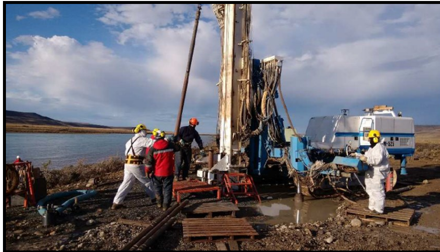
Figura 5.1: Perforadora SOILMEC SM-525
