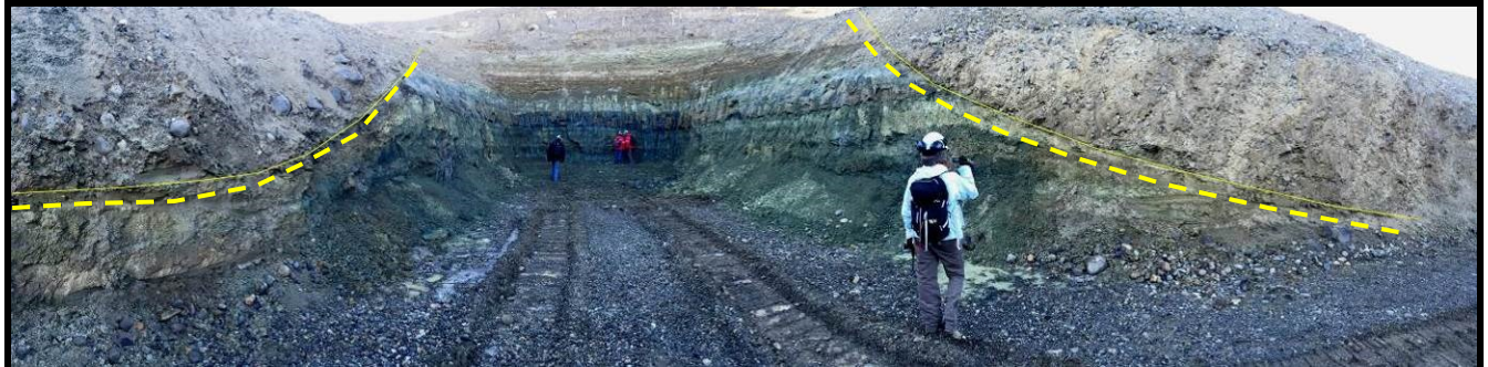
Figura 9.11: Corte transversal de un deslizamiento rotacional. Se observa claramente el plano de falla curvo (resaltado con traza amarilla) a ambos lados de la excavación, que pone en contacto por falla a las sedimentitas terciarias de la Formacion Santa Cruz con el till alojado de la Morenas del Cerro Fortaleza que las sobreyace. La falla curva se dispone en forma subhorizontal en la sección que intercepta la superficie de la pendiente.
