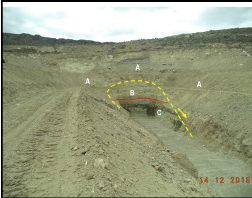
Figura 5.50: Vista general de la excavación de la trinchera de acceso mostrando los distintos materiales encontrados (A: depósitos de till complejos, B: Fm Santa Cruz alterada, C: Fm Santa Cruz sana y competente)
