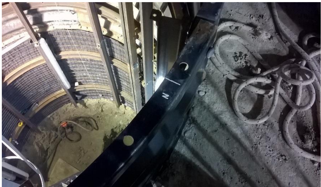
Figura 2.1: fotografía del Norte marcado en la chapa liner para poder realizar los mapeos.
