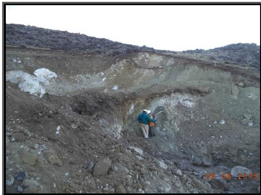
Figura 4.13: Estratos de la Fm. Santa Cruz inclinados hacia el NW producto de un deslizamiento rotacional – Margen izquierda
